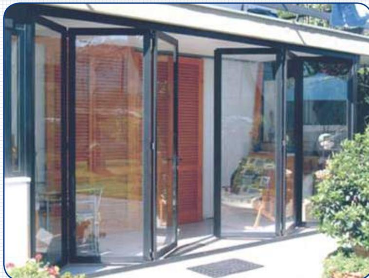
Le ante sono supportate da carrelli scorrevoli lungo la guida portante superiore e un'anta è collegata all'altra mediante cerniere che consentono una rotazione di 180° l'una rispetto all'altra. Tale rotazione permette la fuoriuscita a sbalzo delle singole ante, in modo da poterle raccogliere a una estremità. Chiuse a libro le ante accostate occupano un minimo ingombro. Le cerniere di movimentazione e apertura ante hanno perni estraibili per facilitare la pulizia esterna della veranda.
